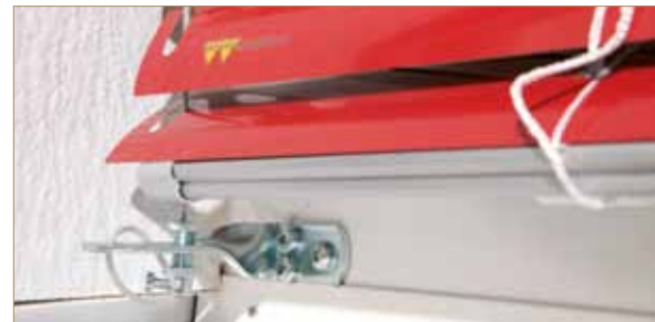
Seilabspannung Außenjalousie
