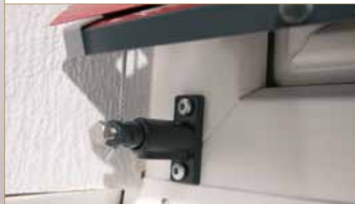
Seilabspannung Außenraffstore
